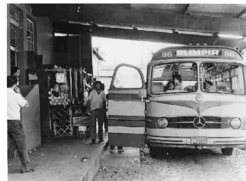
Edifício da antiga rodoviária - década de 70
