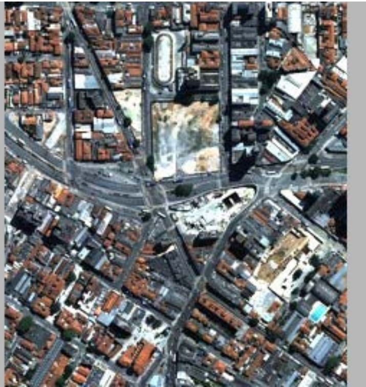
figs. 22 e 23, obras e resultado na largo da batata, respectivamente fonte: acervo pessoal
