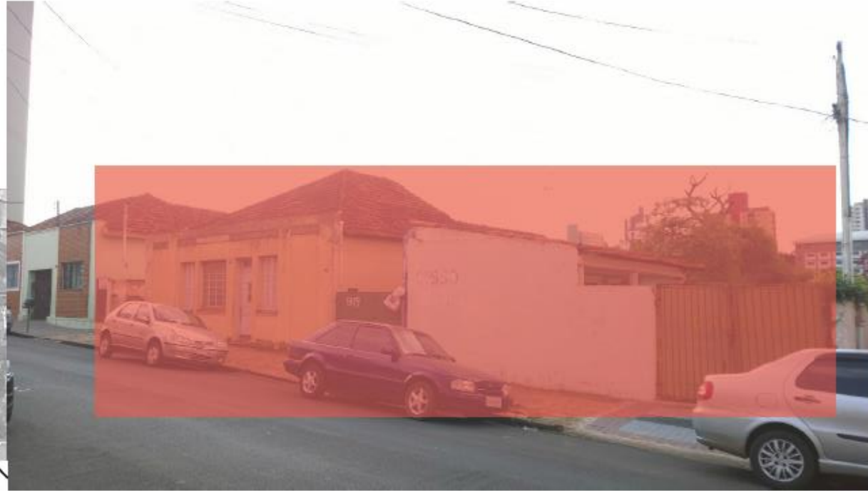
acesso da Rua Treze de Maio
